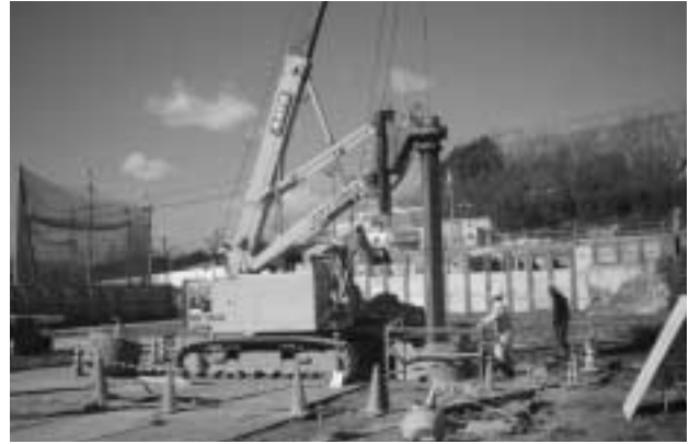
工事現場(平成17年2月2日)
