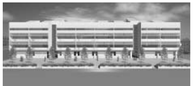
高等学校新校舎南側外観
