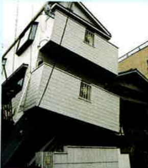
1階の間口方向の壁量が不足して到壊した木造個人住宅。(東灘区)
