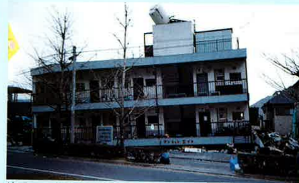
ピロティで壁が少なかった為1階がつぶれた鉄骨造のマンション。
