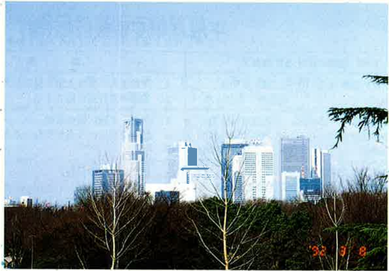
NHKによく出る風景 右側の工事中のビルが エステックオフィス棟 その左が教学高層棟
