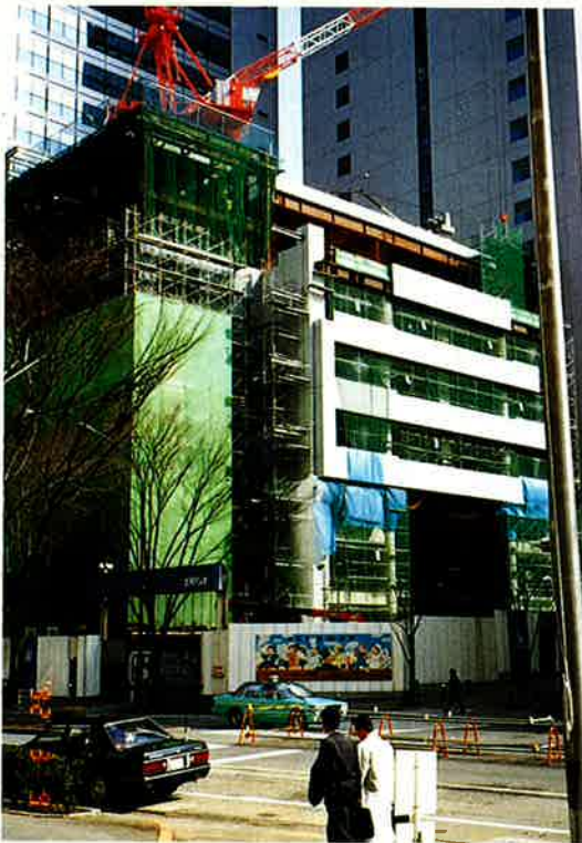
工事中の教学中層棟
