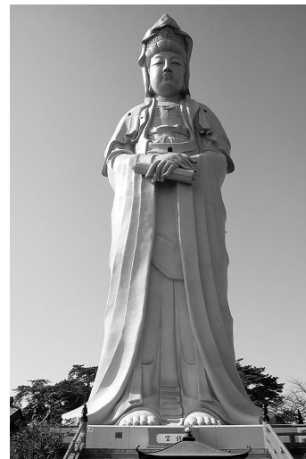
現存する建築群⑤ 「高崎観音」 (実施設計：石川文二郎／竣工：1926年／卒業：1935年〈第48回〉)
